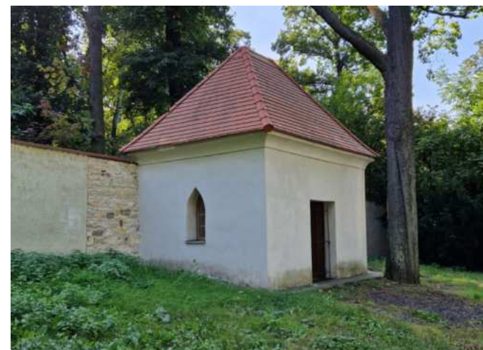
Bývalá márnice u zdi Obory Hvězda
