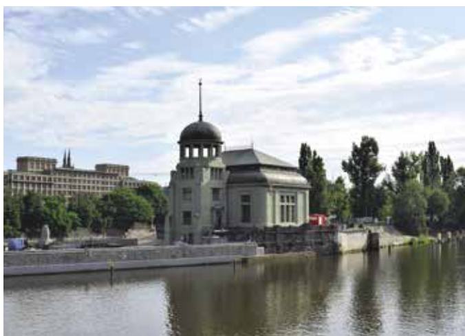
Obr. 16. Praha 7-Holešovice, čp. 1340, ppč. 2335, ostrov Štvanice, vodní elektrárna. Elektrárna na Štvanici, současný stav (foto autor, 2019).
