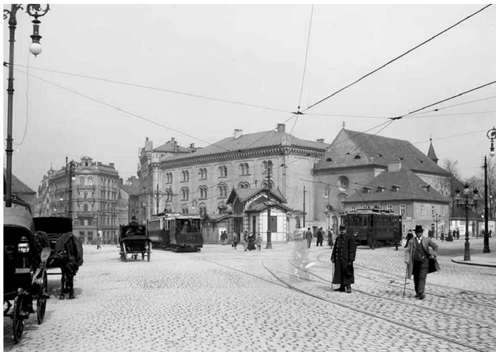
Obr. 25. Jindřich Eckert, 1900–1901: Přepínací stanice 3 kV na Josefském náměstí (dnes nám. Republiky). Sloužila jako zapínací stanice veřejného osvětlení a česká elektrická dráha až do roku 1929, kdy byla zbořena (Archiv hl. m. Prahy, Sbirka fotografií, sign. XII 584).
