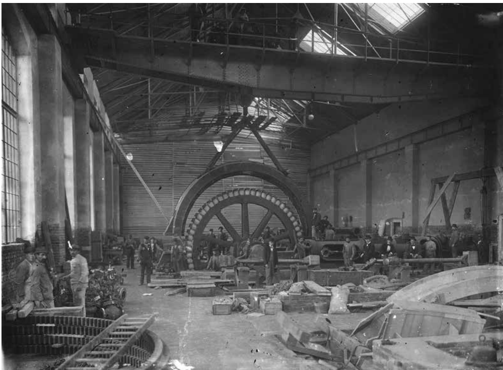
Obr. 10. Jindřich Eckert, 1899–1900: Pohled do strojovny haly Ústřední elektrárny Elektrických podniků v Holešovicích čp. 1. Právě probíhá montáž vrchní poloviny statoru generátoru na rotor pomocí portálového jeřábu. Generátor od firmy Františka Křížíka byl vyroben až v roce 1904, měl výkon 2000 kW a dával proud o napětí 3000 V (Archiv hl. m. Prahy, Sběrka fotografií, sign. VI 76/10 b).
