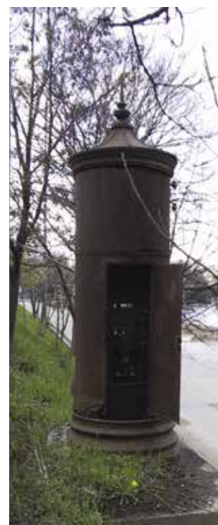
Obr. 24. Praha 5-Smíchov, ppč. 5042/2, Strakonická, distribuční 3 kV trafostanice u vjezdu pro nákladní automobily Smíchovského přístavu, dnes zaniklá (foto L. Špaček, 2001).
