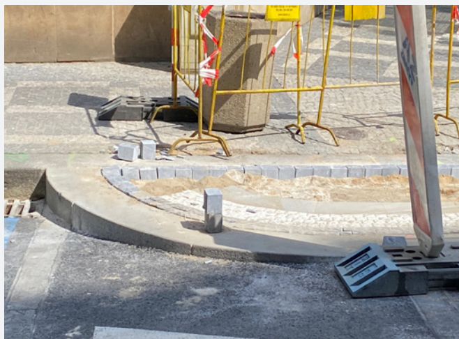
● Snížený obrubník pro vybudování přechodu pro chodce. Kostky pro mozaiky ve vyrábějí také z probarvaného betonu s reliéfním povrchem pro signální a varovné pásy. Barevně jsou sladěny s přírodním kamenem.
