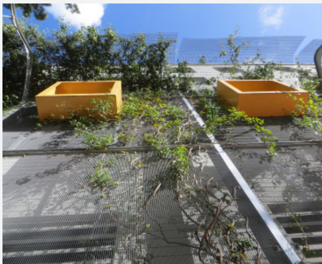
● Jemná síť, která opláštíuje budovu, představuje podklad, na němž vytváří popínavá rostlina efekt krajky. Zajímavý je detail řešení oken. Doplnit zdroj
