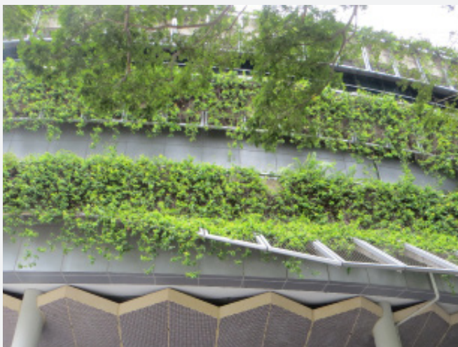
● Popínavky na konstrukci vytvářejí zajímavý efekt jemně členěné zelené fasády. Doplnit zdroj.
