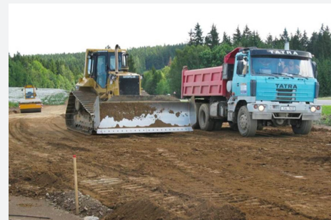
● Upravená zemní pláň před následným hutněním.
