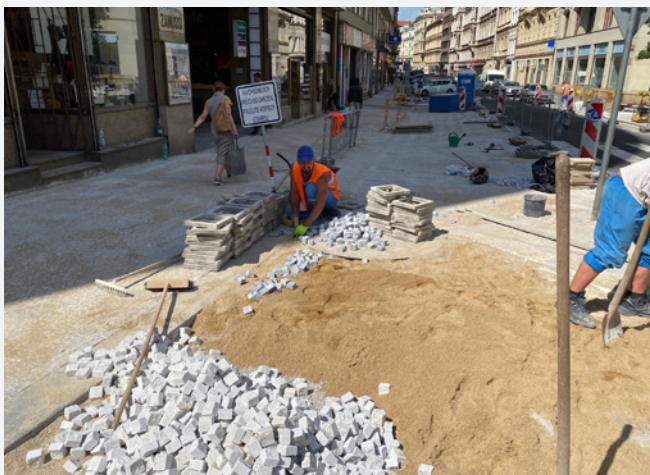
● Příprava pokladu pro kladení mozaiky.
