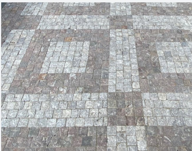
● Vzor „sedmdesátka s netypicky velkou dámou“ kladený na kolmo.
