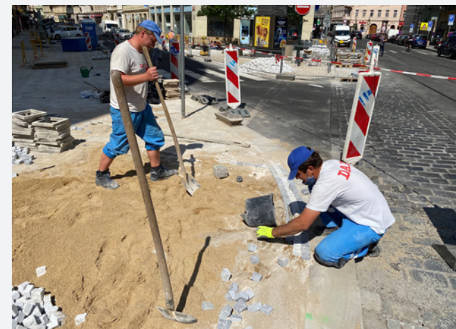
● Kladení varovného pásu u přechodu.
