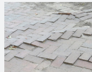
● Problém v mělce rostoucích kořenech stromů nebo ve nestejněm stlačitelném podkladu (vlevo).
