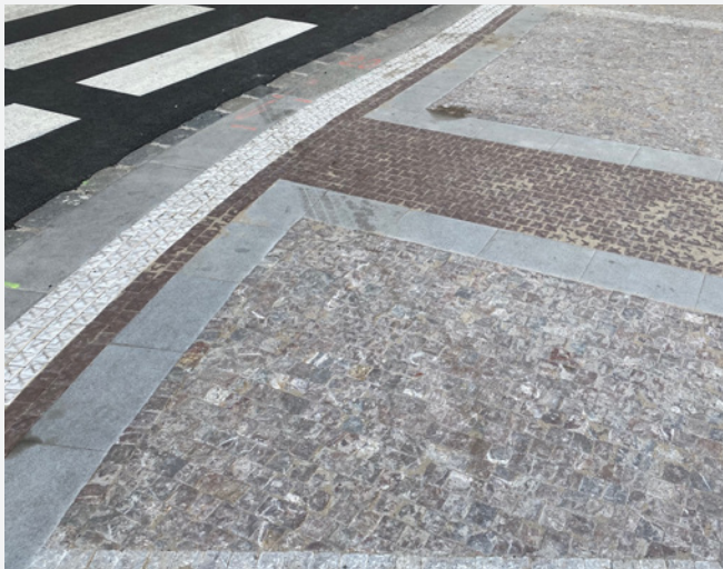
● Signální a varovné pásy u přechodu pro chodce vytvořené z betonových kostek přizpůsobených pražské mozaice.
