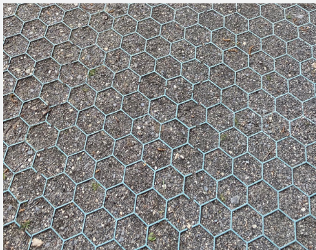
● Varianta vyztužení mlatového povrchu plastovou voštinovou mříží (Karlovy Vary, ČR). Použití plastové mříže je potřeba pečlivě zvážit s ohledem na kontext.
