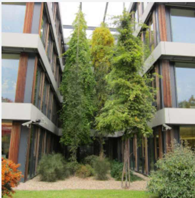
● Popínavé rostliny na jednoduché konstrukci z lanek vytvářejí v atriu budovy bohatou vertikální zeleň. Doplnit zdroj.
