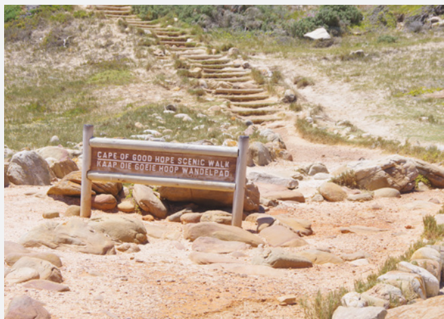
● Chodník s minimálními úpravami se ztuhněným štěrkopískem a přírodními kameny (The Cape of Good Hope, JAR)..
