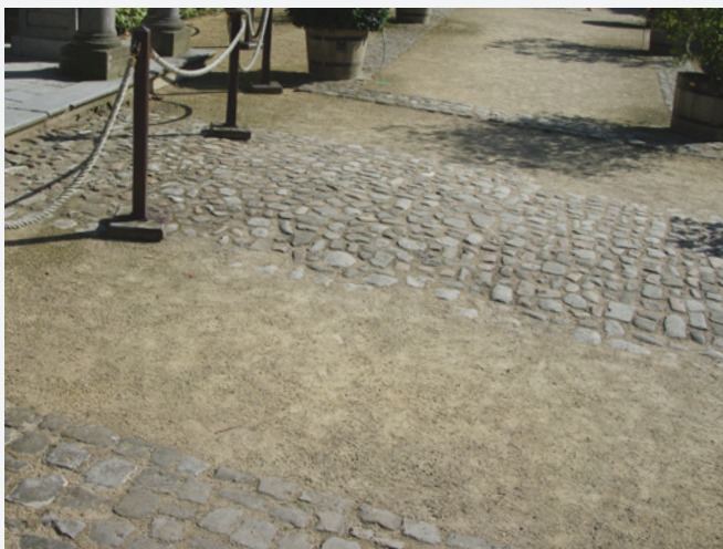
● Mlatový povrch chodníku s přejezdy z nepravidelné kamenné dlažby (Würzburg, Německo).
