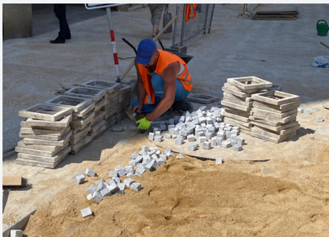
● Pokládání mozaikového chodníku. Šablony jsou pro vytváření vzoru „dáma“. Před pracovníkem je viditelná oblouková hrana z ocelové pásoviny, která je vhodná například pro vytvoření prostoru pro krycí mříž u stromu.
