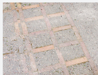
● Keramická dlažba z desek – dlaždic (La Calla, Španělsko; vlevo). Nevhodná kombinace keramických cihel a mlatového povrchu. Vzor se ztrácí a chodník působí neuspořádaným dojmem (vpravo).
