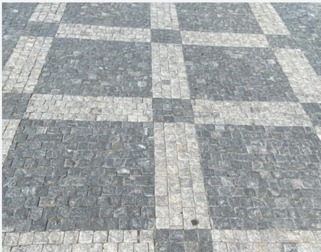
● Vzor „sedmdesátka“ kladený na kolmo, v pozadí vzor „sedmdesátka s dámou“ kladený na kolmo.
