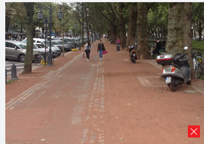
● Mlatový povrch z antuky lemovaný přídlažbou z kamenných kostek a cyklostezkou s asfaltovým povrchem. Nevhodná kombinace je patrná na první pohled. Znečištění ploch s tvrdým povrchem způsobené splavováním volných zrn z mlatového povrchu srážkovou vodou je značné. Navíc je pevný povrch se znečištěním jemnými zrny značně kluzký.
