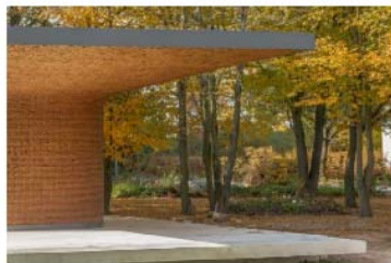
Obrázek 84 – vykanzolaný strop pavilónu v kampusu ČZU
