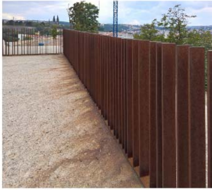
Obrázek 115 – stejně zábradlí při kolmém pohledu působí naprosto transparentně, nezakrývá pohled na Vyšehrad; v podélném úhlu pohledu (na pravé straně) vytváří kompaktní stěnu; MCA ateliér
